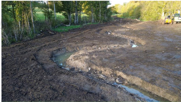
Reméandrage en fond de talweg du cours du Badard avec la technique du lit emboîté (gauche). Effacement des 2/3 d'un plan d'eau et reméandrage en fond de talweg du lit du Badard.
