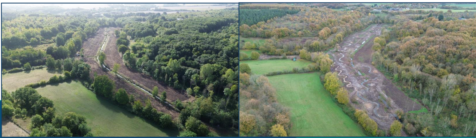
Vue drone avant et après travaux (novembre 2025)
