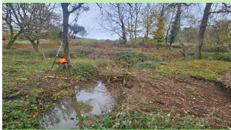
Mise en œuvre d'une solution fondée sur la nature visant la remise en fond de vallée du cours d'eau, par la création d'un ouvrage castor mimétique (OCM) – (dénomination distinguée par la DDT86 de celui de barrage). Il est réalisé à partir de terre et de branches prélevées sur site, afin de favoriser les débordements et permettre la reconnexion des écoulements en fond de talweg.
