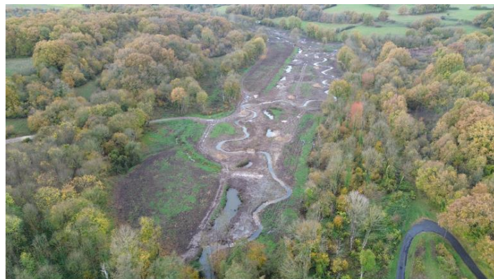
Vue drone après travaux
